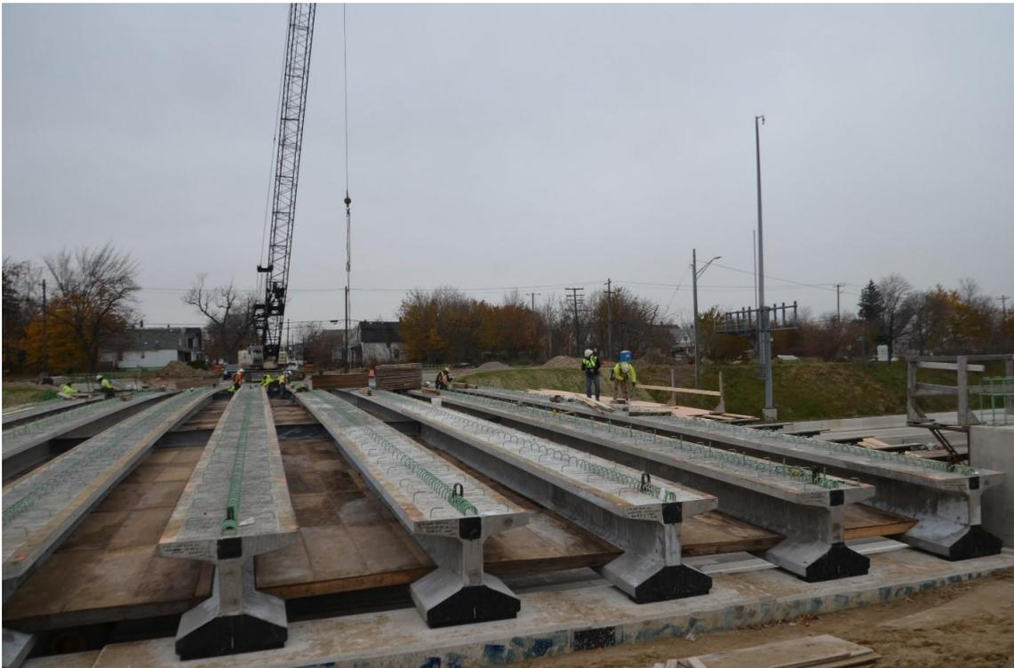
これらのコンクリート桁は、I-94 近代化プロジェクトの一環として昨年の 11 月に設置された。I-94 にかかる Burn Road 橋の桁は、炭素繊維複合材ケーブルで補強されており、腐食することなく、より大きな強度をもたらしている。炭素繊維複合材ケーブルは、ゲームチェンジャーとなりうる技術と考えられている。
